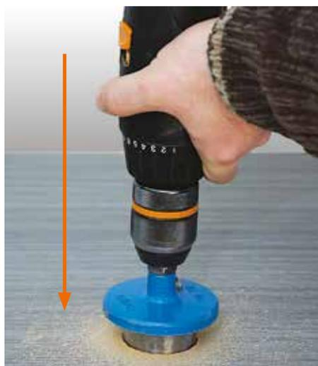
Просверлите отверстие в выбранном месте с помощью обыкновенной круговой пилки (оптимально диаметром 45 мм).
